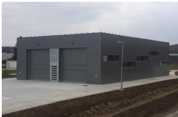
Tehnička građevina – pralište
