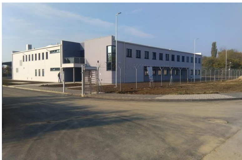
Slika 24. Građevina razmjestivoga komunikacijskog modula
